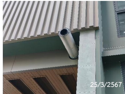
พัดลมระบายอากาศห้องไฟฟ้า
