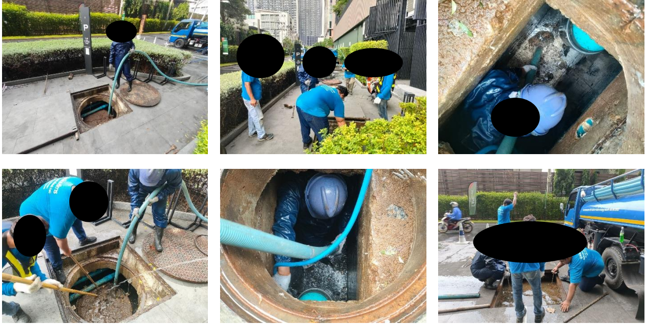
ภาพที่ 2.2-19 การสูบล้างก่อนจากระบบบำบัดน้ำเสีย
