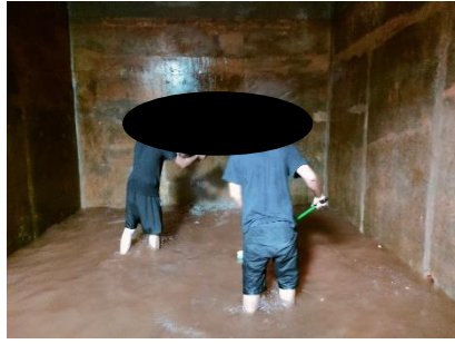
ภาพที่ 2.2-16 การล้างถังเก็บน้ำใช้
